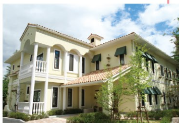
実験実習棟 食栄館 南仏プロバンス地方をイメージして建築された食物栄養学科を中心とした実験実習棟です。
