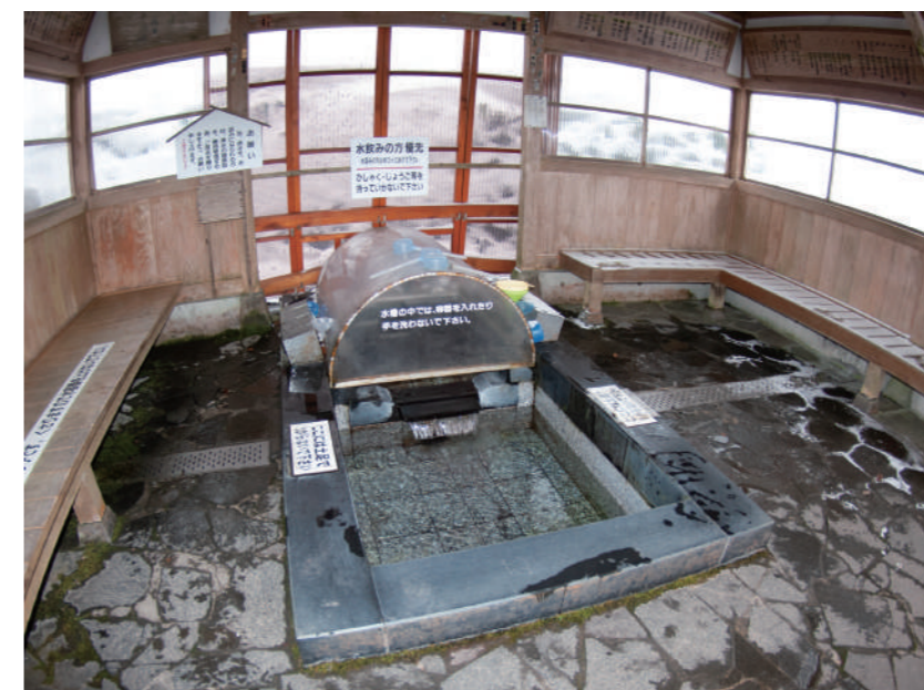
■ 強清水の湧水口 湧水口はコンクリートと御影石で整えられ、ゴミが入らないようにプラスチックのカバーが掛けられている。 硬度11.7
