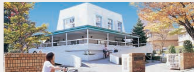
20 サイクルハウス 自転車やバイクを約220台駐輪できます。この建物の隣には駐車場があり、条件を満たせば自動車での通学も可能です。
