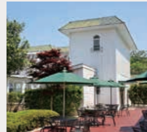
15 工芸棟 2つの工芸教室があり、美術系の授業などで利用されています。
